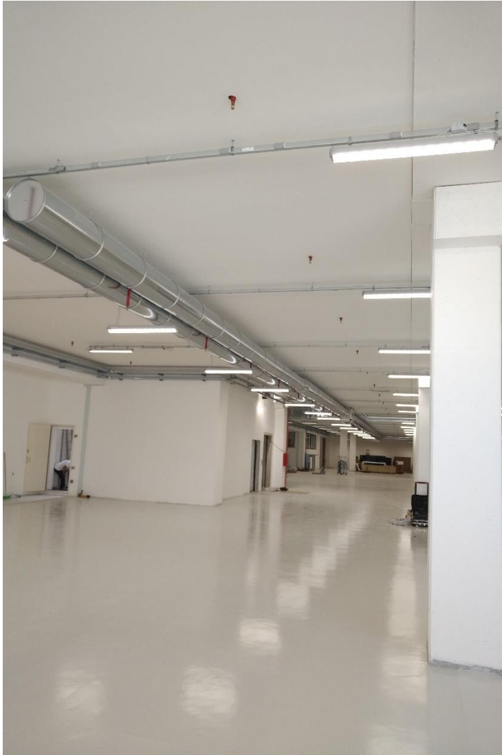
IMPIANTI A DOPPIA FUNZIONE HVAC – CONTROLLO DEL FUMO
