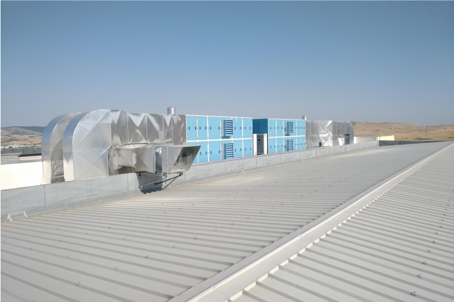
IMPIANTI A DOPPIA FUNZIONE HVAC – CONTROLLO DEL FUMO
