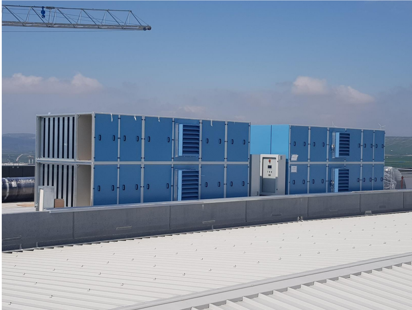
IMPIANTI A DOPPIA FUNZIONE HVAC – CONTROLLO DEL FUMO
